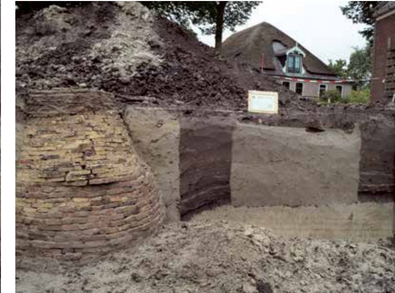
Links een 19de-eeuwse waterput in de stal van de stolpboerderij en rechts een zandpakket als grondverbetering.
