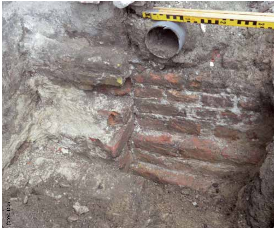
Detail van de 14de-eeuwse fundering met daarboven de 19de- of 20ste-eeuwse zijgevel van de huidige bebouwing en 14de-16de-eeuws opgaand werk dat koud tegen het linkerdeel van de 14de-eeuwse fundering is gebouwd.
