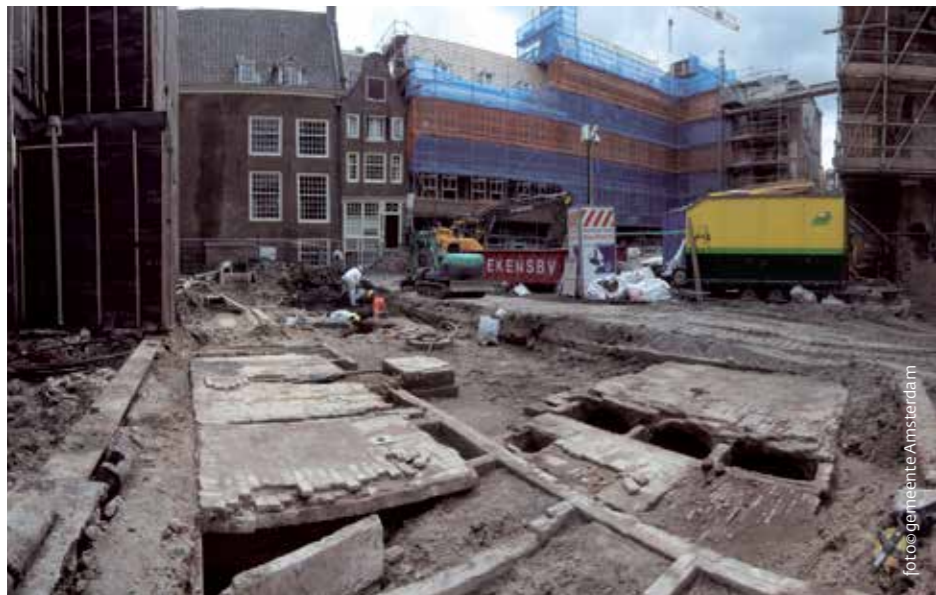
Het achterhuis van ziederij De Clock met de bakken met compartimenten die zijn afgedekt door een platgewelf, gezien richting de Wijdsteeg.
