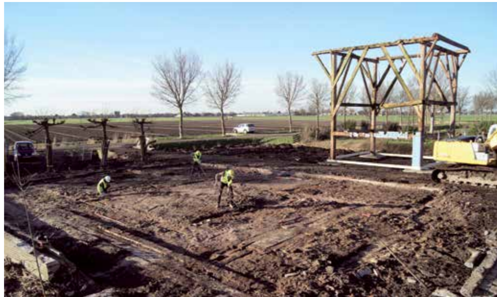
Op de voorgrond de blootgelegde funderingen van de stolpboerderij, daarachter het vierkant dat is hergebruikt in de nieuwbouw.
