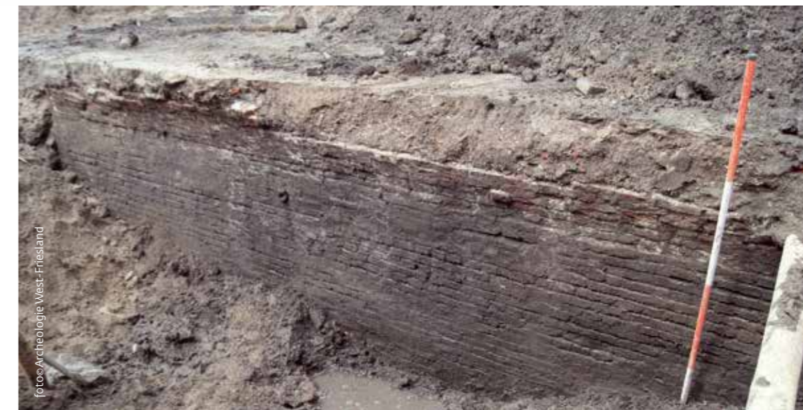
Gedeelte van de zuidmuur van de overkluizing. Halverwege de muur zit een ijzeren ring. Aan de bovenkant is de aanzet van het tongewelf zichtbaar. In 1693 is het gewelf afgebroken en is dit deel van de gracht gedempt.
