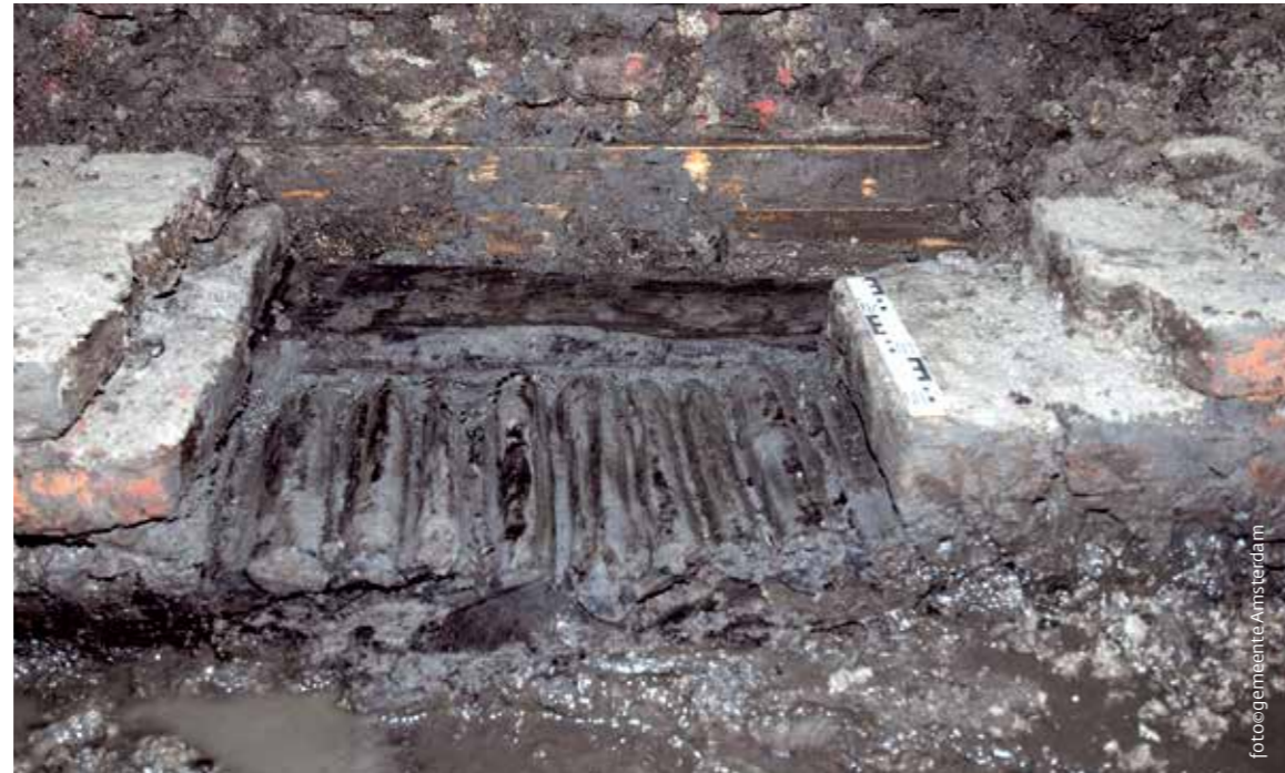
Een fundering van liggende stammetjes elzenhout, gevonden onder Warmoesstraat 64.
