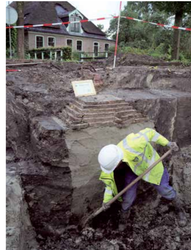
De bakstenen poeren van de vierkantpalen waren gefundeerd op een ingegraven pakket zand.
