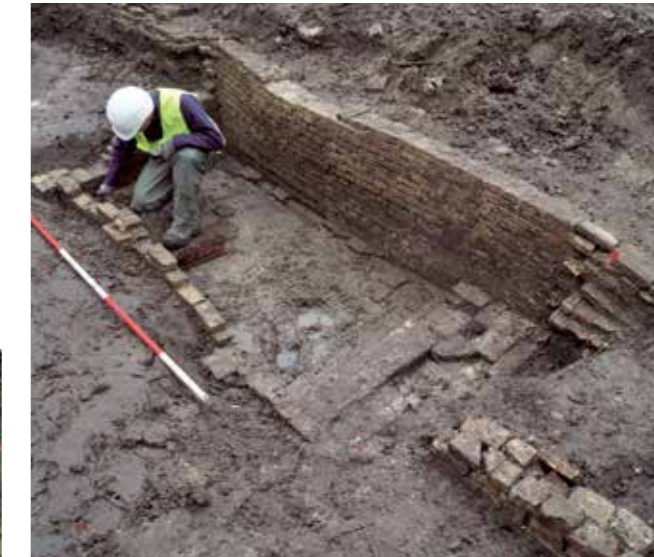
Het uitgraven van een 17de-eeuwse kelder.
