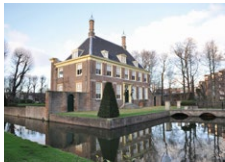
Buitenplaats Akerendam in centrum Beverwijk.
