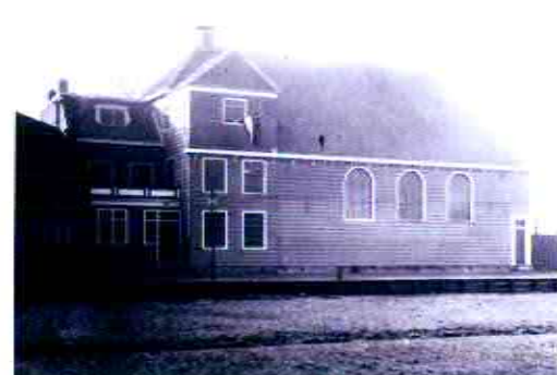
Rond 1950 is de pastorie uitgebreid en is er een dakkapel toegevoegd. [GAZ]
