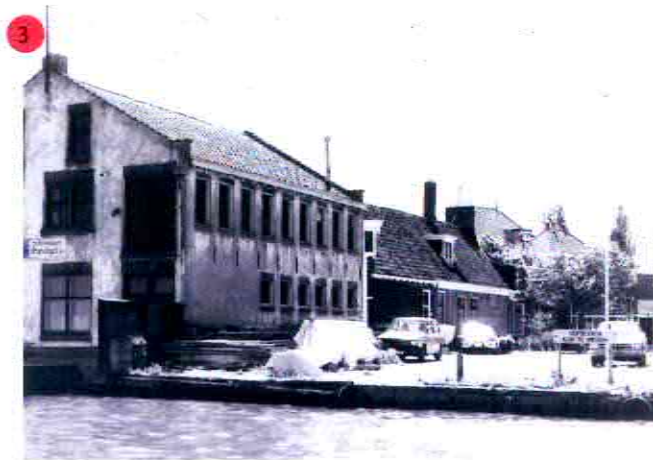
Lagedijk, Zaandijk. Molenmakerij Saendijck BV, gesticht in 1975 door Smit en Maas. [GAZ]
